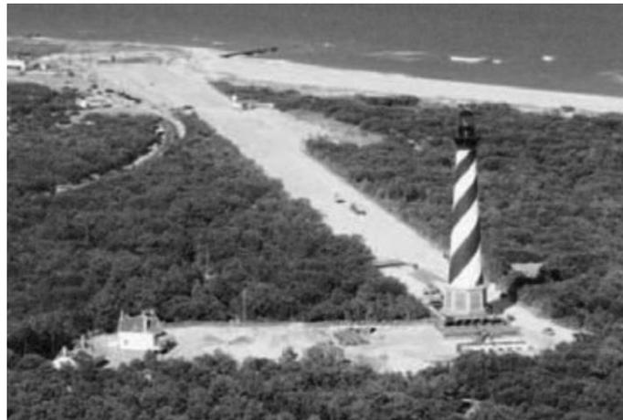
Figura 12. Traslado del faro del cabo Hatteras de Carolina del Norte en 1999. Se trasladó 488 metros de la línea de costa al verse amenazado por la erosión costera. (Foto de Drew Wilson © 1999, *Virginian-Pilot.*)
