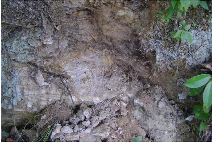
**Figura 26. Fotografía 12. Caída en bloques del material a la hora de realizar el nicho.**
